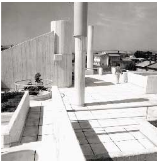
Edificio della Cassa dei Risparmi a Forlì in fase di costruzione.
