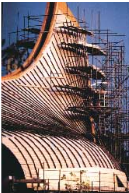
Guscio del tetto in lamellare per la Chiesa di San Cristoforo a Forlì.
