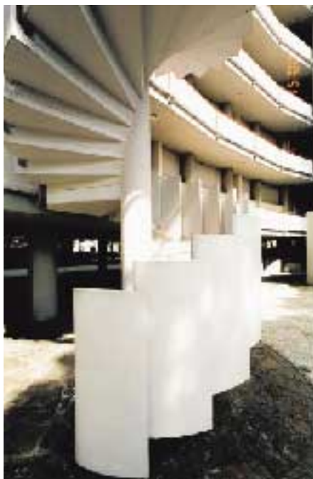
Scala in cemento armato bianco prefabbricata. Residence turistico, 1971.
