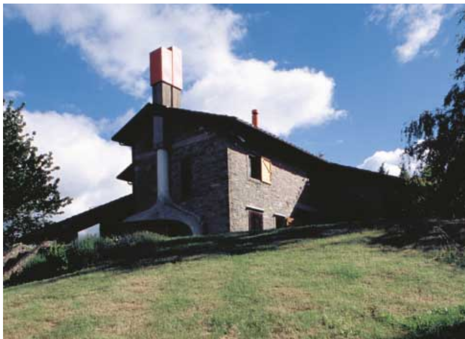
Casa di Corzano a Bagno di Romagna (1968). Intervento di restauro condotto anticipando di 15 anni le teorie della Cop. Himmelblau a Vienna.
